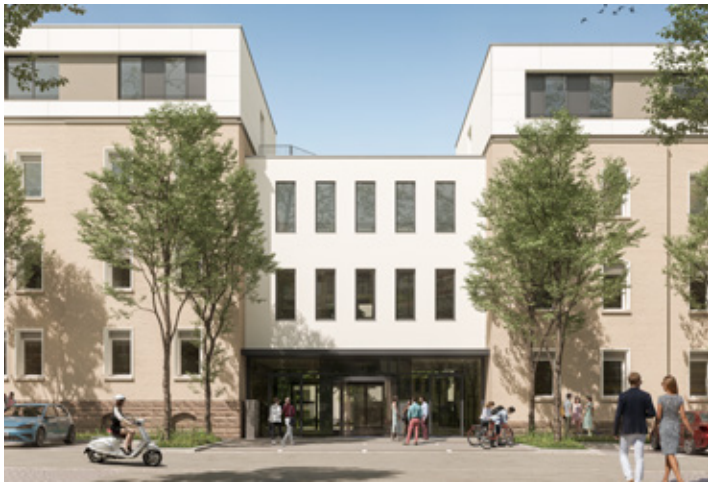
Vor der Vollendung: Die Ausbaurbeiten im JägerhofQuartier liefen im Jahr 2024 auf Hochtouren. Alle Wohnungen und Gewerbeflächen werden im ersten Halbjahr 2025 fertiggestellt.
