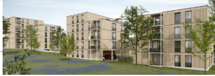
Kostensparende und zukunftsfähige Bauweise: 51 Neubaumietwohnungen werden im 3. Bauabschnitt B1 in Grünbühl. living entstehen.
