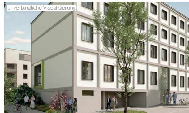
Fassade Jägerhofquartier - Ansicht Alt-Württemberg-Allee
