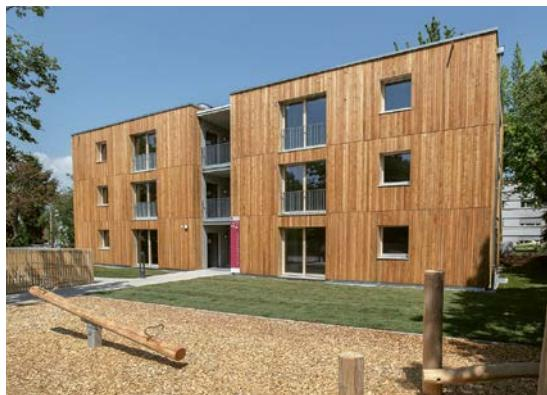
Als aktiver Partner im Innovationsnetzwerk LivingLab Ludwigsburg haben wir federführend die serielle Holzmassivbauweise CUBE 11 entwickelt. Mit diesen modernen, würfelförmigen Gebäuden realisieren wir bei kurzen Planungs- und Bauzeiten energieeffizienten, bezahlbaren Wohnraum in hoher Qualität, der sich zudem ansprechend in das gewachsene Stadtbild einfügt.
