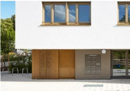
Unterschiedlich ausformulierte Balkon- und Eingangselemente aus gestanztem Blech bzw. Streckmetall verleihen den Punkthäusern Individualität.
