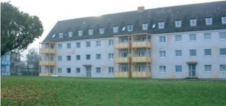
Einstmals Offizierswohnungen der US-Armee – heute eine beliebte Wohnanlage in Ludwigsburg
