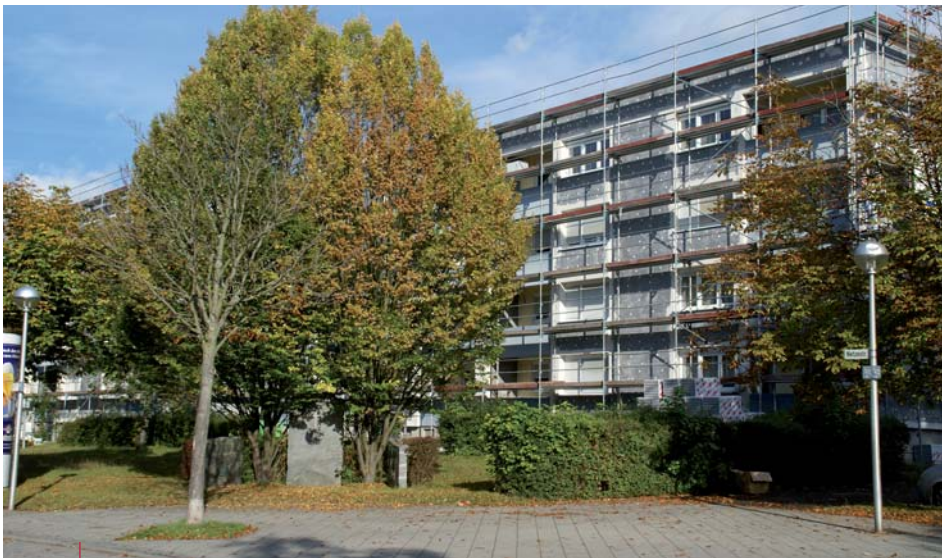
Die WBL modernisiert drei Häuser mit 56 Wohnungen
