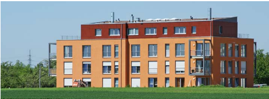
Der Ludwigsburger Architekt Michael Schelle hat für die WBL mit dem Wohnhaus Mitländerstraße ein echtes Schmuckstück gebaut.
