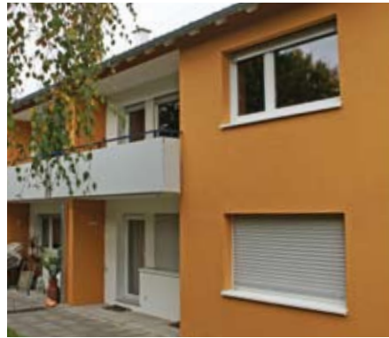
Die neue Außenhaut sieht schön aus und hält dicht.
