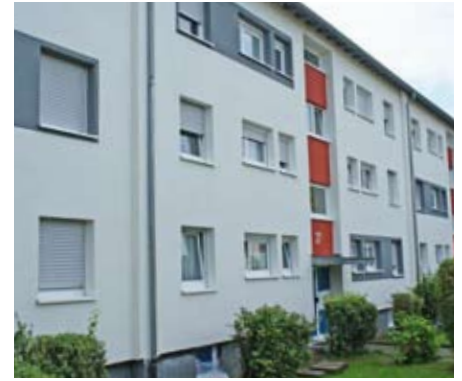
Neue Fenster sorgen auch für ein besseres Raumklima.
