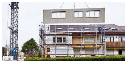
Die aufgesetzten Fertigbauteile enthalten die Fenster und den Großteil der Gebäudetechnik.
