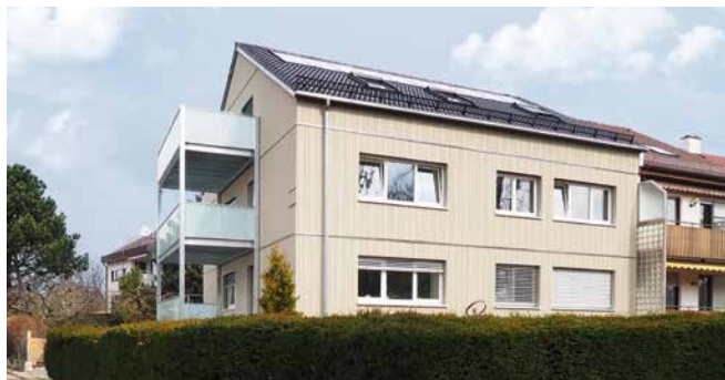
Nach der Sanierung: Durch die energieeffiziente Modernisierung wird das Bestandsgebäude nahezu zu einem Nullenergiehaus.
