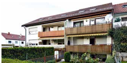
Vor der Sanierung: die Doppelhaushälfte in der Karl-Dieter-Straße im Stil der 1970er-Jahre
