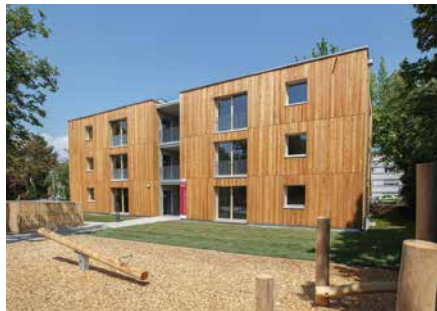
CUBE 11: die neuen Gebäude in der Brucknerstraße
