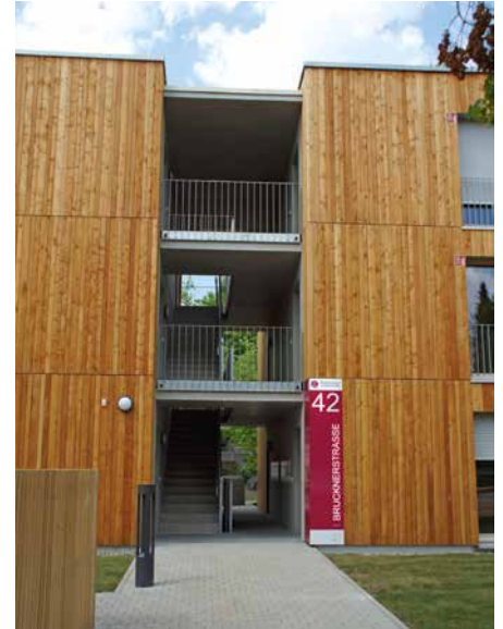
Das Treppenhaus besteht aus Stahlbetonfertigteilen.
